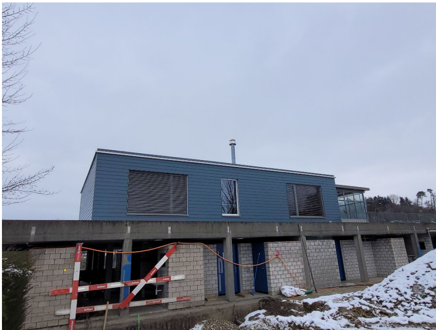
Ansicht der Betriebsleiterwohnung
