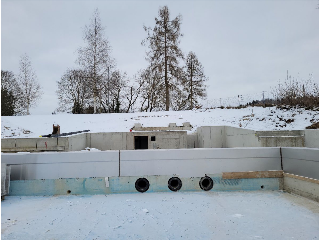
Fundament der neuen Rutschbahn
